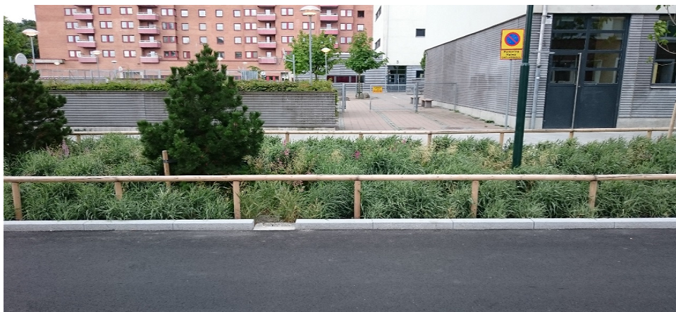
Figur 41: Nedsänkt växtbädd med inlopp genom nedsänkt kantsten.
